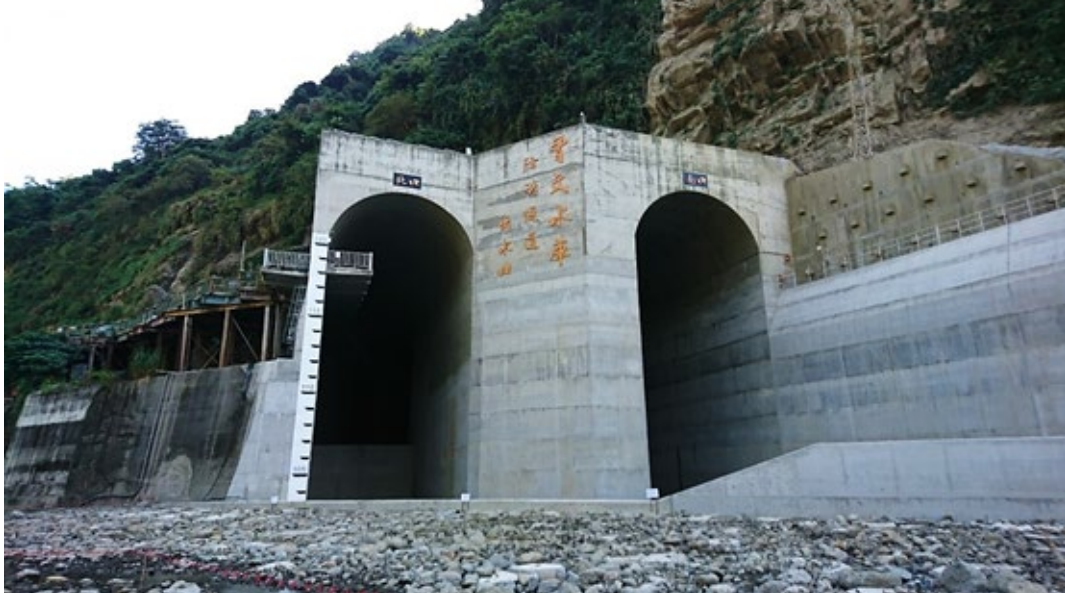
圖3 曾文水庫防淤隧道出水口
