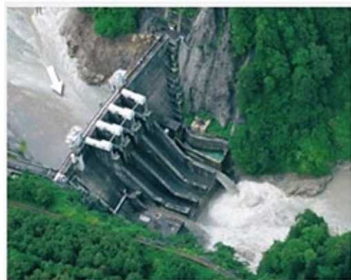
通砂中の出し平ダム (H18)
