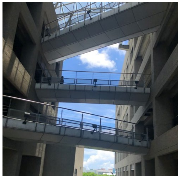
水工所的試驗建築物，內部有不同規模大小的水槽
